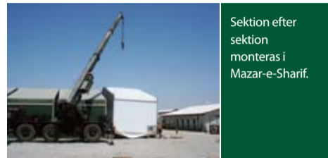
Medarbetare från Hallbyggarna-Jonsereds arbetar tillsammans med svenska FN-soldater med att resa ett nytt väderskydd.
