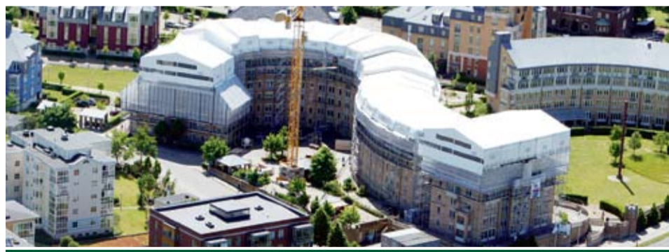
Det jättelika väderskyddet Gibson från Hallbyggarna-Jonsereds täcker den brandhärjade fastigheten Potatisåkern i Malmö.
